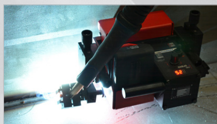
Toortsplaatsing aan beide kanten
