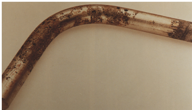
figuur 4.7 Putvormige corrosie
